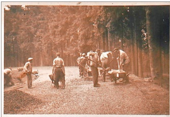
1936 - 1938 Straßenbau auf der R 281 unterhalb der Werra-Quelle
