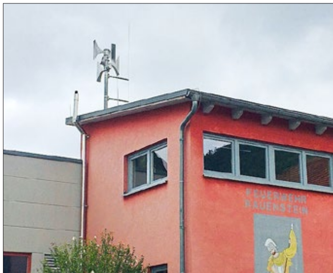
Die elektronische Sirene auf dem Dach des Feuerwehrgerätehauses Rauenstein
